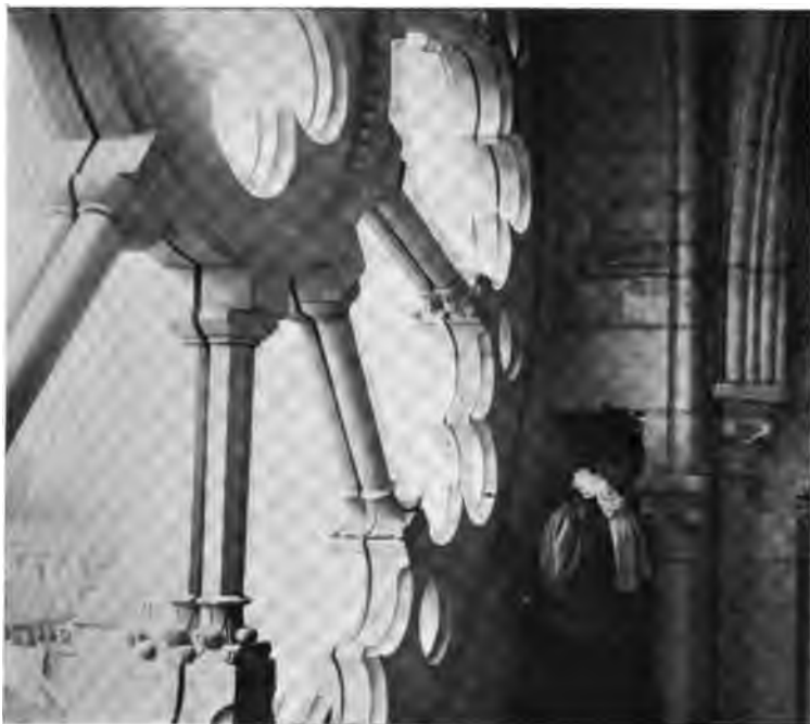
Fig. 83. — Rose de l'église de Bougival indiquant le tracé des meneaux à colonnettes jumelles.
